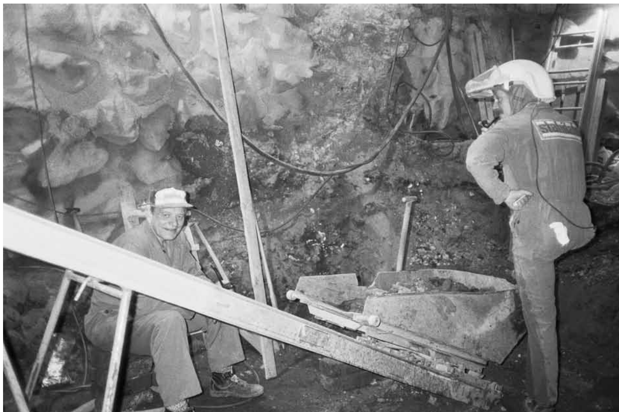
Fig. 4. Bert och Kurre, schaktning i det outgrävda rummet. Foto Göran Fredriksson S 89-0397:20
